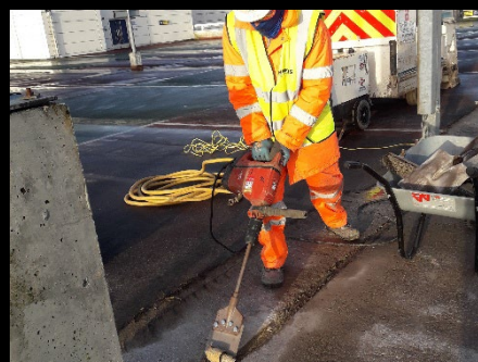
Edge preparation ongoing
